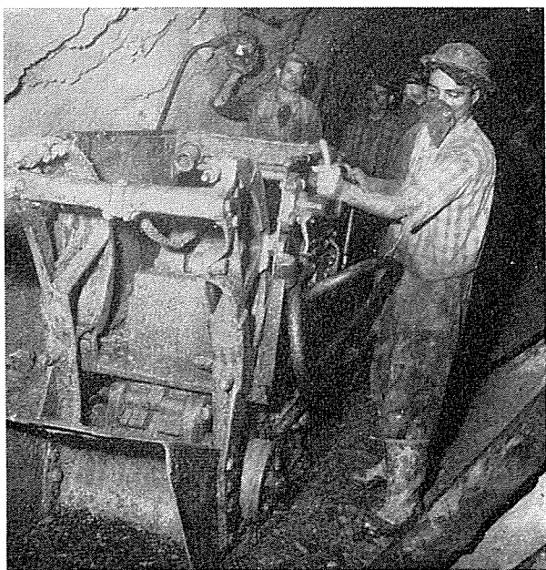
Uma brigada de traçagem procede ao desentulho de uma pega de fogo com o auxílio de uma pá mecânica e farol eléctrico, ambos a ar comprimido.
