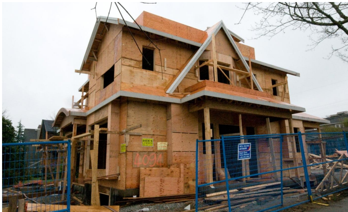
Figura 29 – Papel da madeira na construção na América do Norte (casa em edificação em Vancouver, Canadá).
